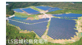
LS宮城松島発電所
