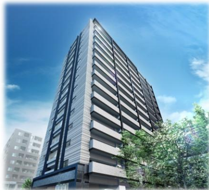
レーベン高崎フレンチア 2015年2月 竣工・引渡予定
