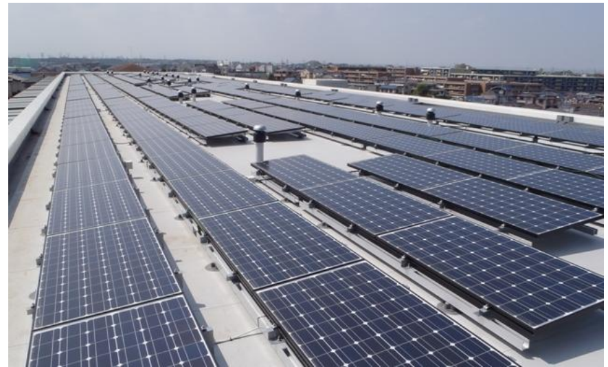
屋上に1住居当たり6枚の太陽光パネルを設置
