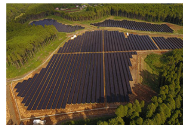
LS千葉山武発電所
