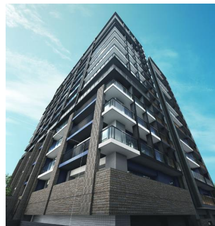
レーベン浦和常盤 THE TOWER
